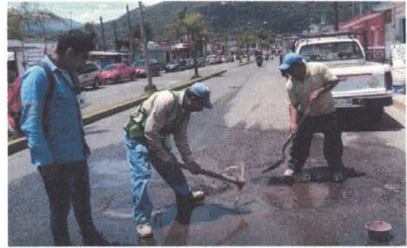
Reparación de fuga en bulevar Miguel Aleman de la Col. Unión y Progreso.
