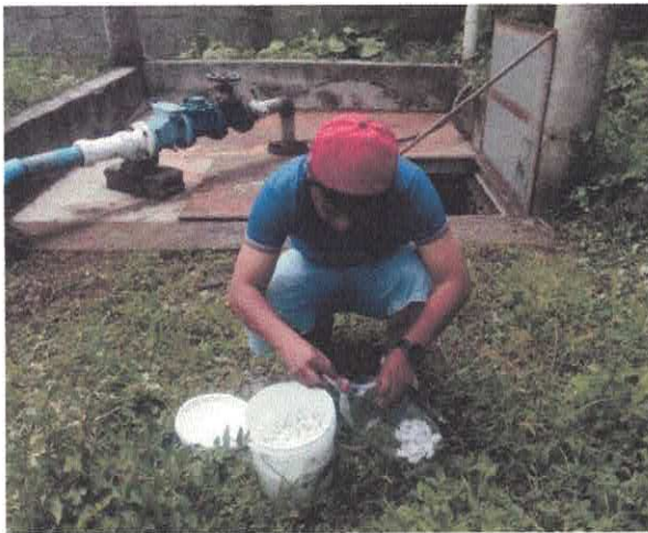
Cloración del sistema de agua Rincón de Capulines. Cloración del sistema de agua Rincón Capulines.
