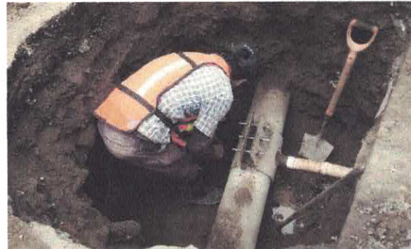
Reparación de fuga sobre carretera a Ixhuatlancillo, frente a capilla de unidad El Cristo.
