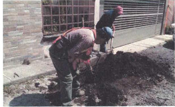
Reparación de fuga en calle Alcatraz de la Col. Las Flores.
