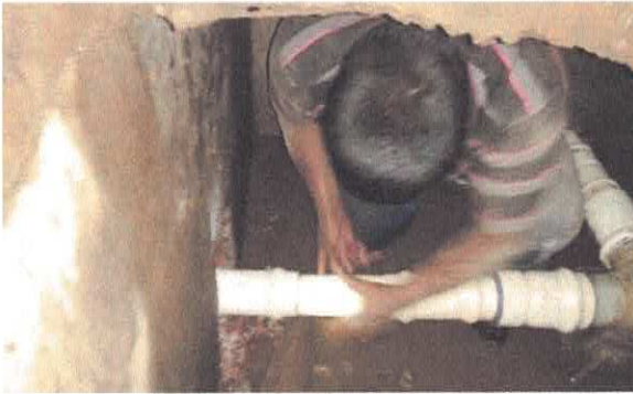
Reparación de tubería general en unidad habitacional El Cristo.
