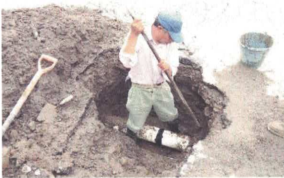
Reparación de fuga en tubo general del Fracc. Valle Dorado.
