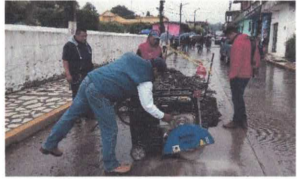
Reparación de fuga en calle Cristóbal Colon en la cabecera municipal.
