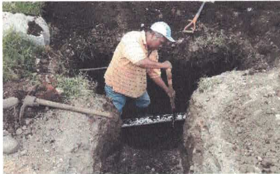
Instalación de un bay paz en la Col. Galaxia
