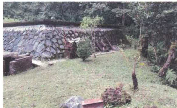
Sistema de agua de la cabecera municipal.
