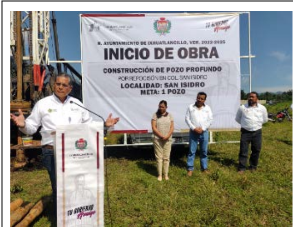
Inicio de obra del pozo profundo en la localidad de San Isidro
