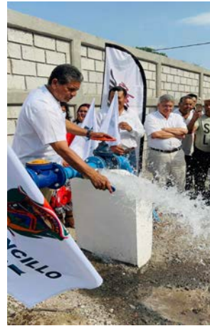
Pozo en sus primeros momentos de operación
