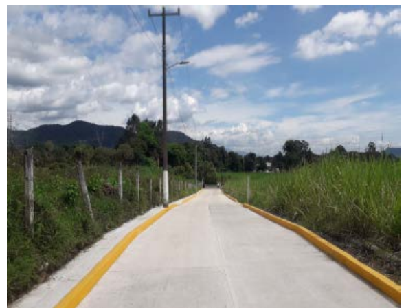
Rehabilitación colonia Antonio Luna localidad de San Isidro.
