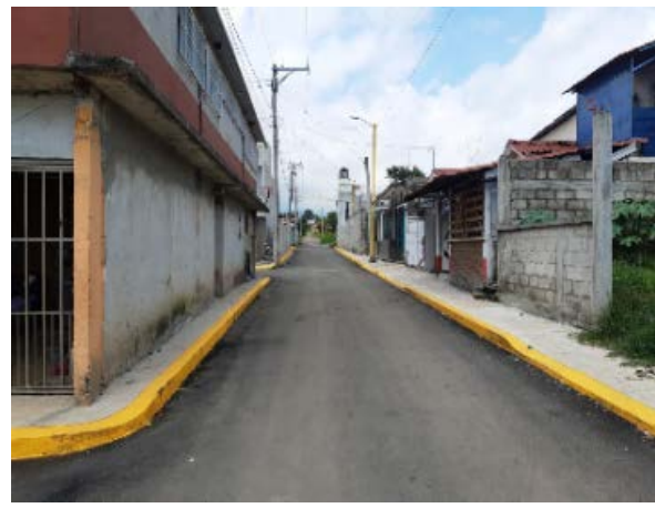
Pavimento en calle de la colonia Las Flores de la localidad de San isidro
